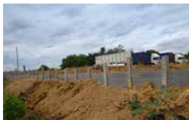
กำแพงกันดินโครงการบริษัทฐานวิศวกรรม
